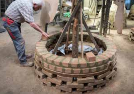
Der Sockel wird eingerichtet.
