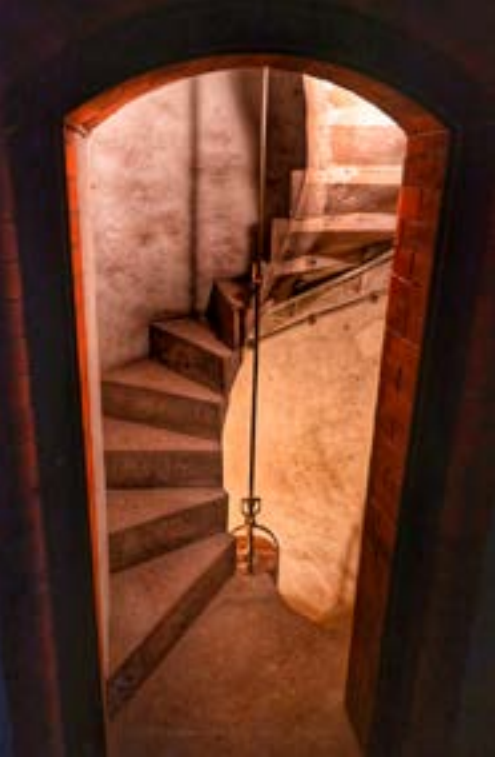
Treppenhaus zum Dachstuhl hinter der Empore
