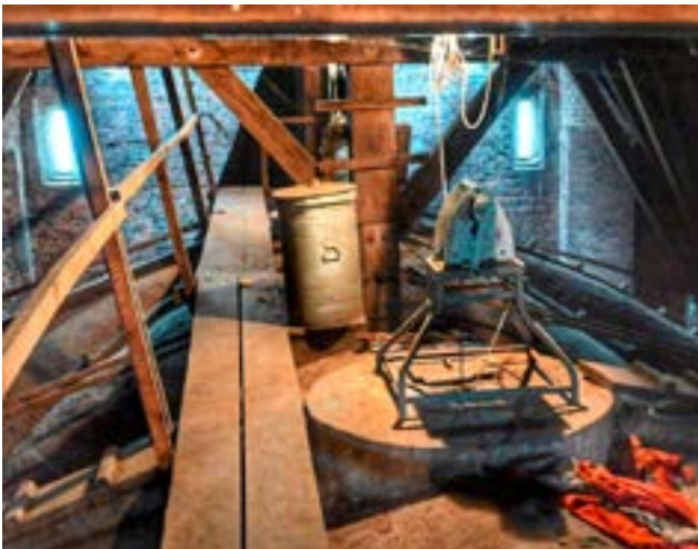
Holzsteg im Dach über dem Deckengewölbe
