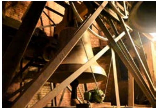
Neue Glocke mit Läutevorrichtung
