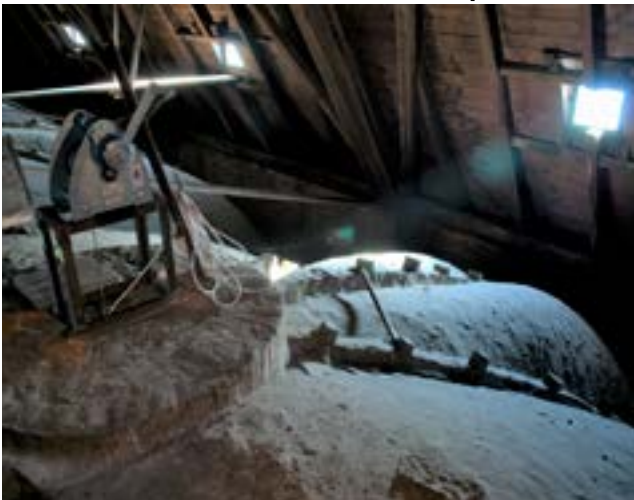
Lichteinfall aus der kleinen Gaube auf der Südseite des Daches über dem Hauptschiff.
